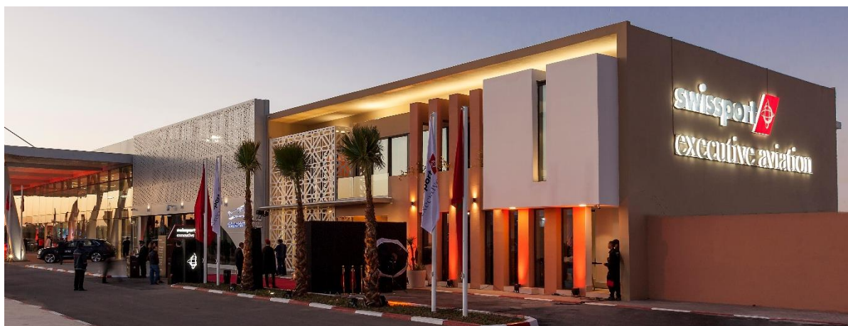
Esplanade d'accueil du terminal aviation d'affaires se Swissport de l'aéroport de Marrakech
