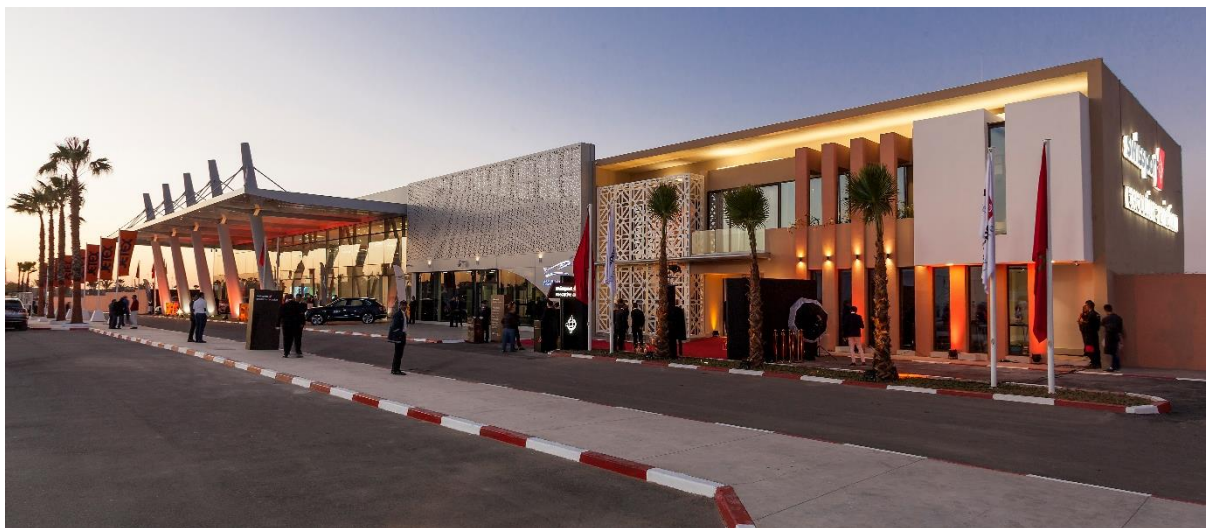
Façade du terminal aviation d'affaire de l'aéroport de Marrakech
